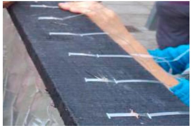
usar el hilo de plástico de botella y vamos a hacer "Punto Festón" en cada unión entre las botellas de abajo y de arriba. ¿Por qué hilo de plástico y no alambre u otra cosa? Porque es muy resistente, no se altera mucho con temperaturas altas o bajas y no se oxida.
