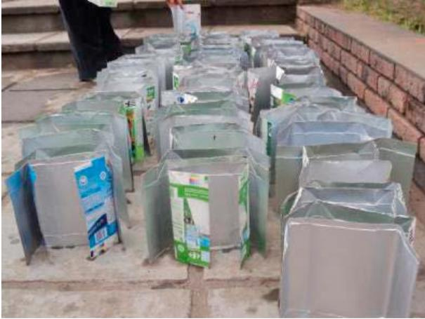
Luego la primer columna de tetra, la clavamos a las maderas del recuadro y luego sigo abrochando y clavando hasta tapar todas las botellas, formando una pared metálica.
